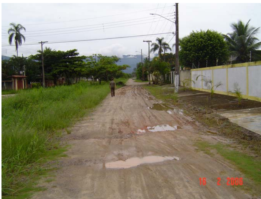
Figura II.5.3-103 - Rua sem pavimentação no bairro de Aruan.
