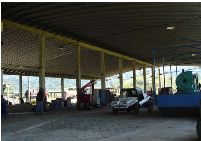
Figura II.5.3-119 - Lavador de máquinas e tratores.
