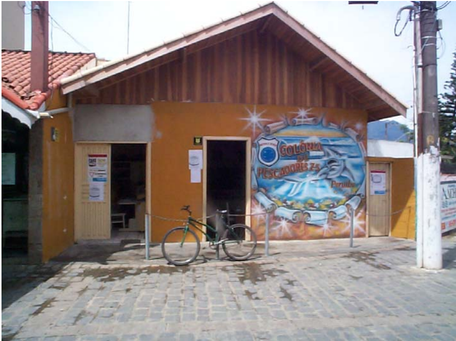
Figura II.5.3-68 – Sede da Colônia de Pescadores Z-05 “Júlio Conceição”, de Peruíbe (SP).
