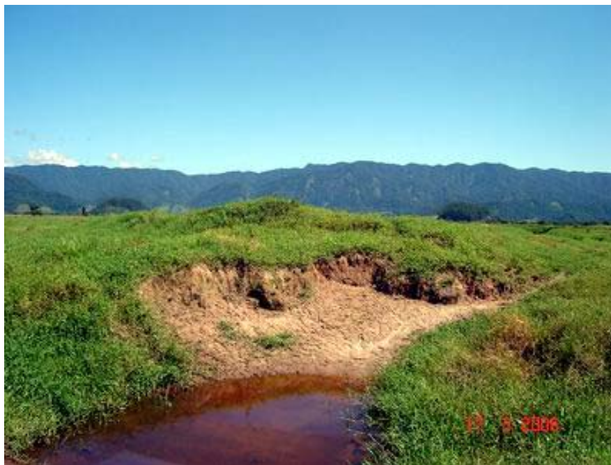
Figura II.5.1.4-18 - Barranco em canal de drenagem aberto a partir do rio Camburu exibindo pacotes arenosos e sua instabilidade.
