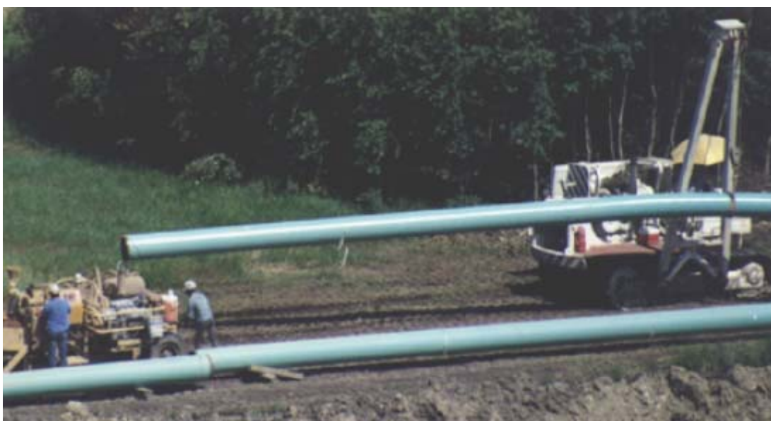
Figura II.2.4.2-44 - Desfile da tubulação ao longo da área de montagem. Fonte: Petrobras.
