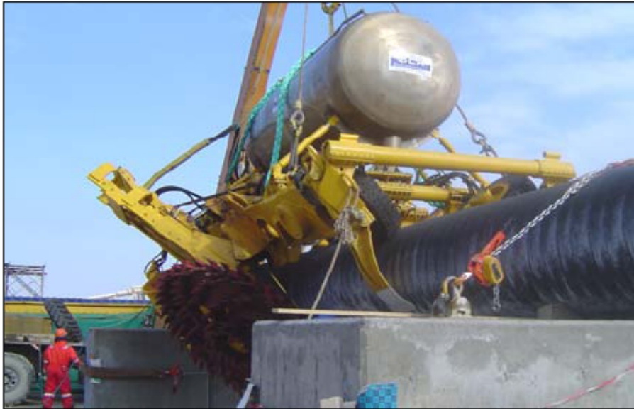
Figura II.2.4.2-40 - Máquina de enterramento equipada com fresa.
