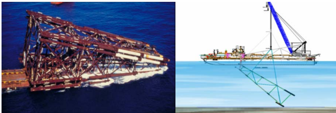
Figura II.2.4.2-27 - Instalação da jaqueta metálica.
