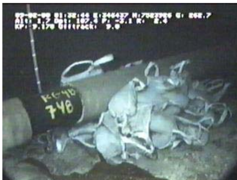
Figura II.2.4.2-34 - Calçamento com sacos de pasta de cimento.
