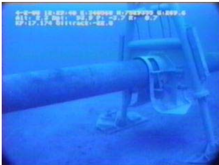
Figura II.2.4.2-33 - Calçamento com suporte mecânico.
