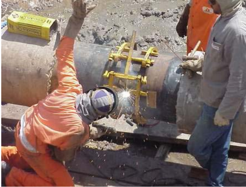
Figura II.2.4.2-45 - Soldagem dos tubos. Fonte: Petrobras.
