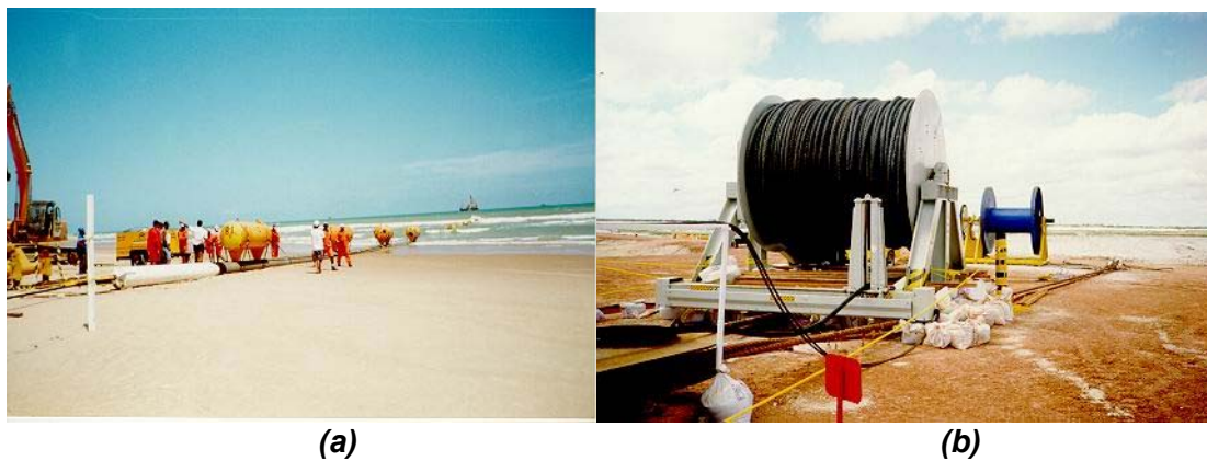
Figura II.2.4.2-38 - Foto ilustrativa da Base Guincho na praia (a). Detalhe do guincho de arraste (b). Fonte: Petrobras
