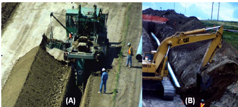
Figura II.2.4.2-43 - Abertura de vala utilizando uma valetadeira (A) e uma retroescavadeira (B).
