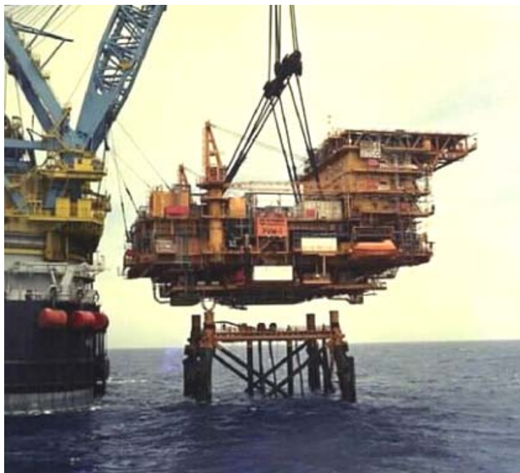
Figura II.2.4.2-28 - Instalação dos módulos da jaqueta.
