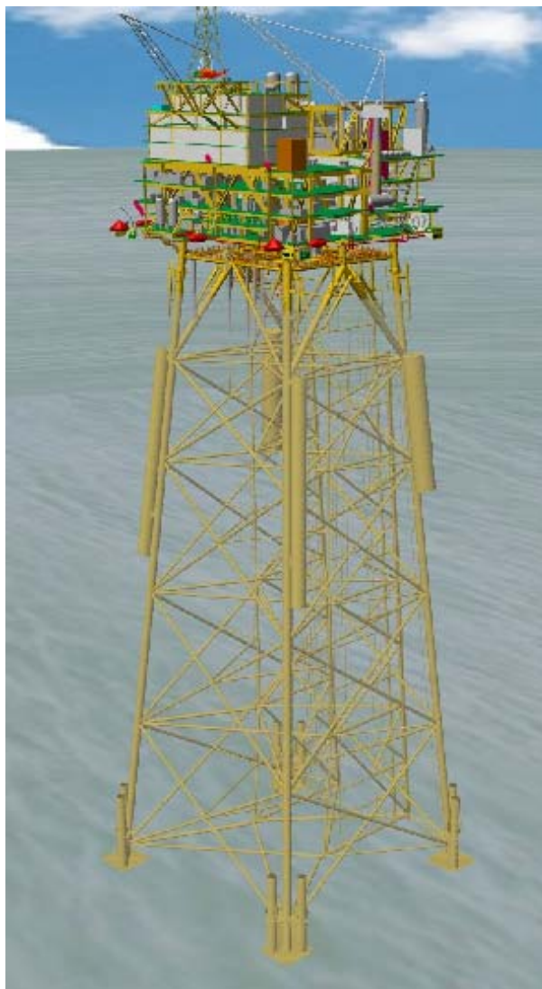
Figura II.2.4.2-6 - Figura ilustrativa da plataforma marítima fixa PMXL-1. Fonte: Petrobras.
