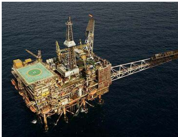
Figura II.3.1.1-1 - Plataforma fixa com sonda modular instalada.
