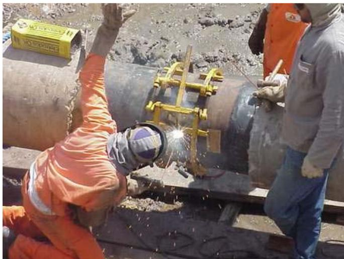
**Figura II.2.4.2-41** - Soldagem dos tubos.
