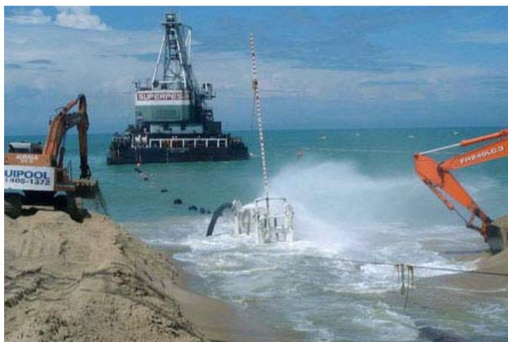
**Figura II.2.4.2-38 - Enterramento do duto por jateamento hidráulico.**
