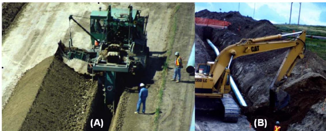
**Figura II.2.4.2-39** - Abertura de vala utilizando uma valetadeira (A) e uma retroescavadeira (B).
