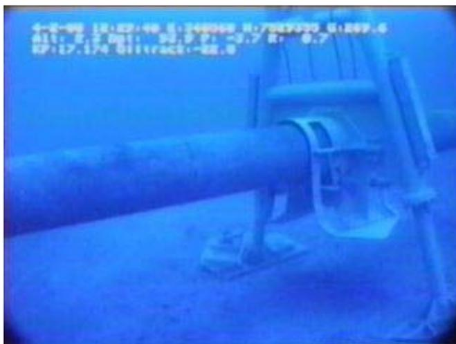
**Figura II.2.4.2-33 - Calçamento com suporte mecânico.** Fonte: PETROBRAS
