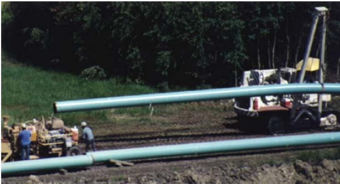
**Figura II.2.4.2-40** - Desfile da tubulação ao longo da área de montagem
