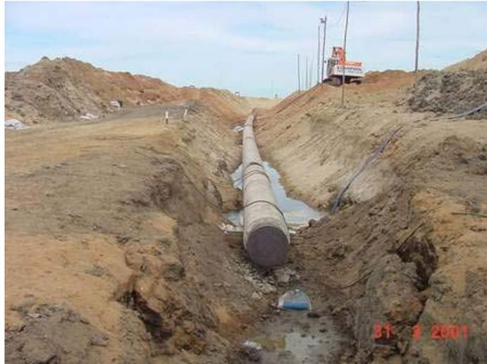
**Figura II.2.4.2-42 - Ilustração de uma vala de escavação para enterramento de duto.** Fonte: PETROBRAS
