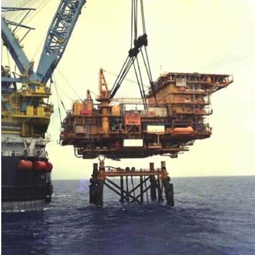
**Figura II.2.4.2-28 - Instalação dos módulos da jaqueta**
