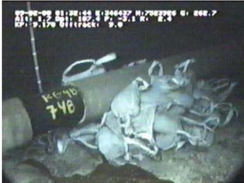
**Figura II.2.4.2-34 - Calçamento com sacos de pasta de cimento.** Fonte: PETROBRAS
