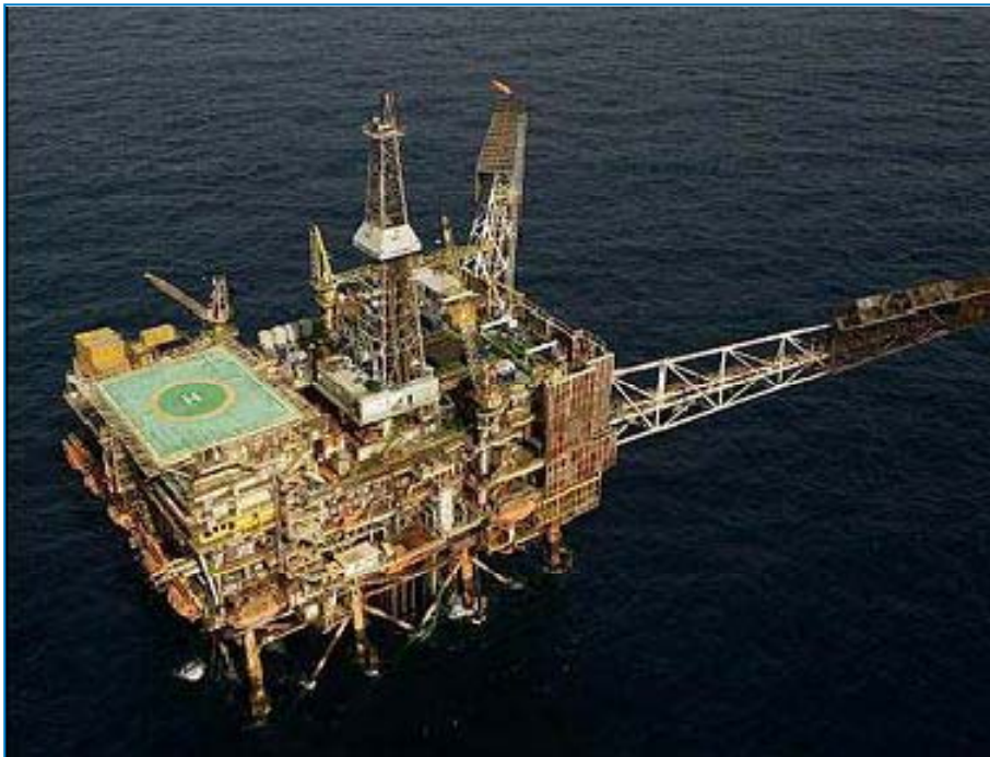
Figura II.3-1 - Plataforma fixa com sonda modular instalada.
