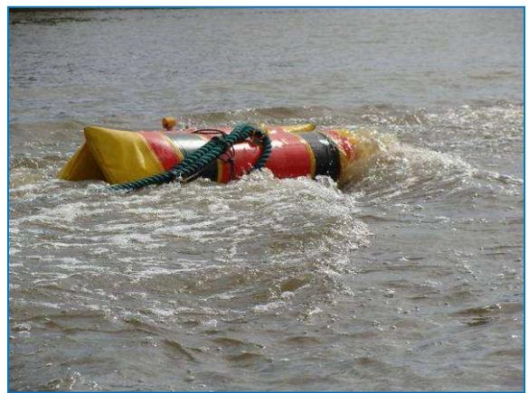
**Figura II.2.4-58** - Detalhe dos flutuadores para lançamento de dutos em superfície.
