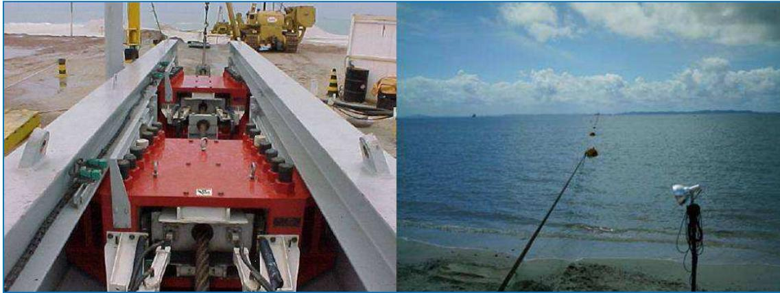
**Figura II.2.4-57** - Equipamento de reboque do duto (CPM 600).
