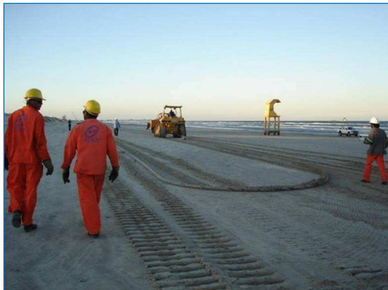
**Figura II.2.4-73** - Exemplo de situação real de desfile do cabo de arraste na praia.
