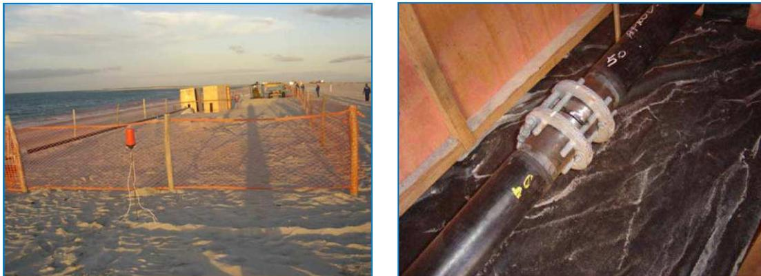
**Figura II.2.4-48** – Vista geral e detalhe de estação de soldagem similar à que será montada no Pólo Atalaia para soldagem dos strings de 600 m.
