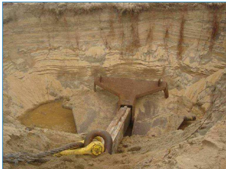
**Figura II.2.4-70** - Ancoragem da base-guincho através de escavação de âncoras.
