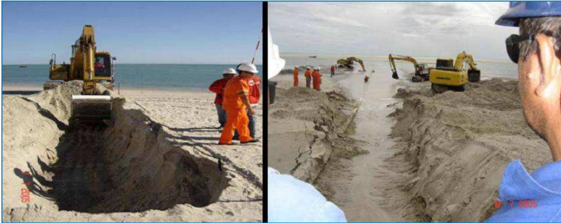
**Figura II.2.4-61** - Confeção de vala para rebaixamento de cota na zona de praia.
