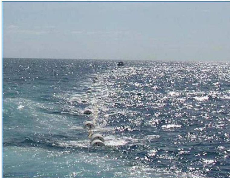
**Figura II.2.4-53** - Detalhe de transporte de duto a “meia-gua”, com flutuadores metálicos.
