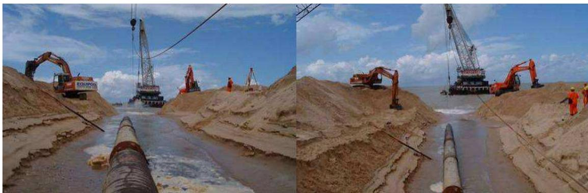
**Figura II.2.4-62** - Metodologia de rebaixamento de cota em área de shore approach.
