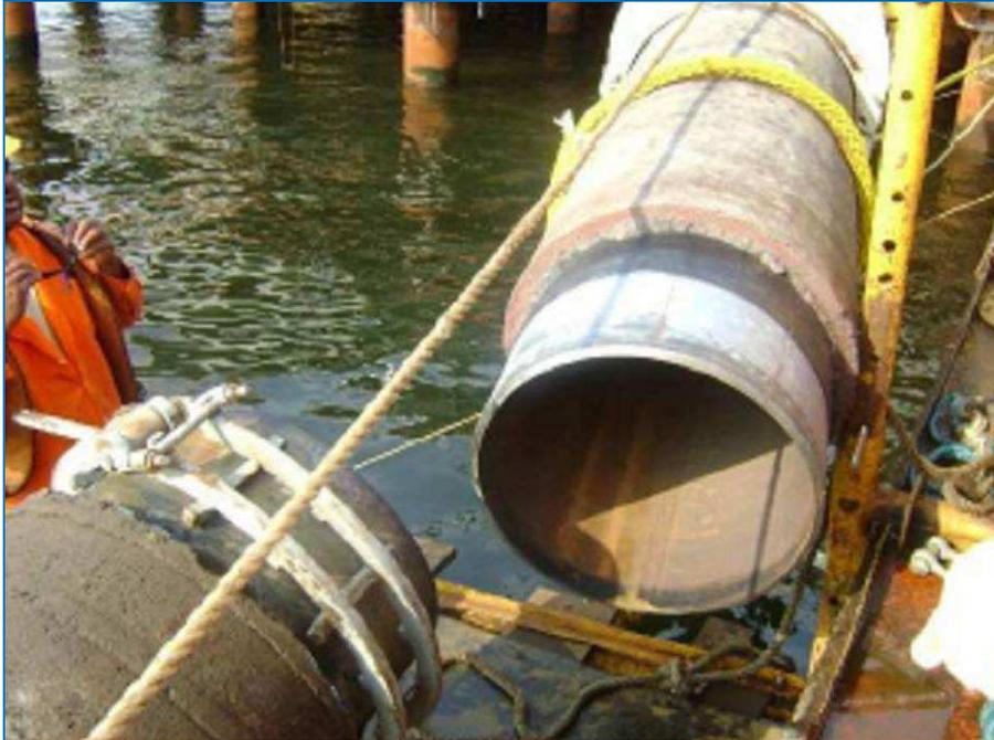
**Figura II.2.4-44** - Segmentos de dutos sendo posicionados para realização de *tie in* de superfície, com soldagem.
