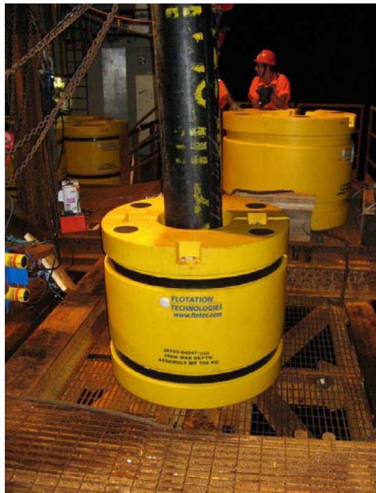
Figura 2.4-33. Foto de instalação de um flutuador.
