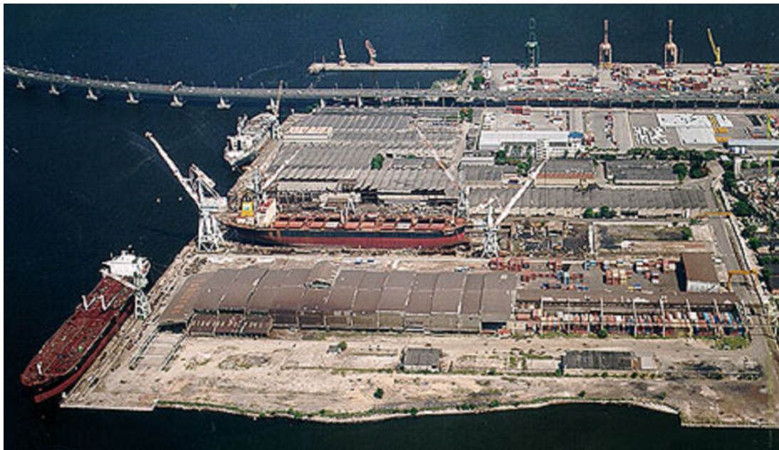
Figura 2.4-35. Vista aérea da Briclog.
