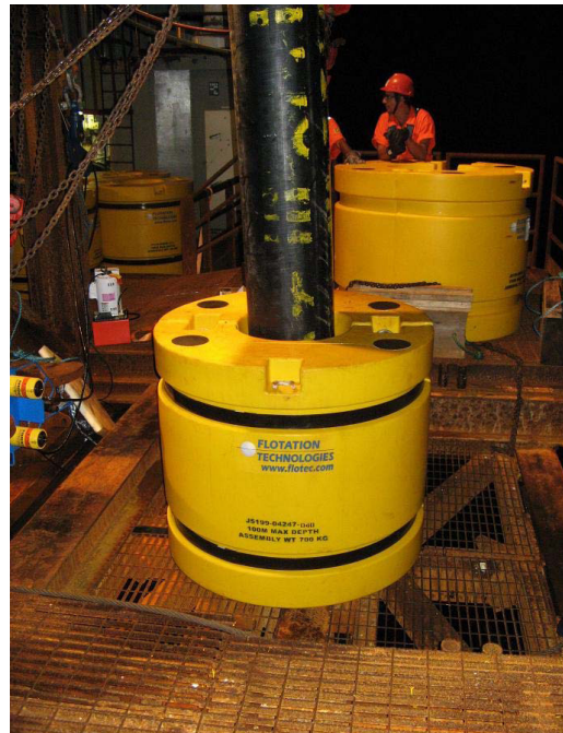
Figura 2.4-33. Foto de instalação de um flutuador.
