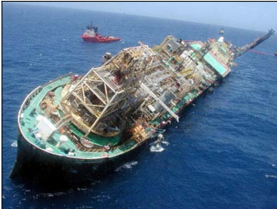
Figura II.8-11 - Acidente na FPSO P-34
