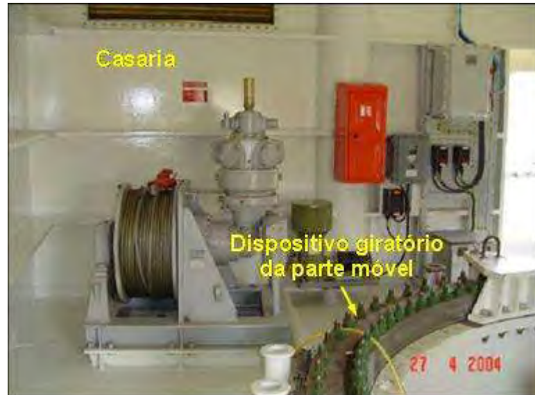
Figura II.2.4-35 - Ilustração do casario e dispositivo giratório da parte móvel.
