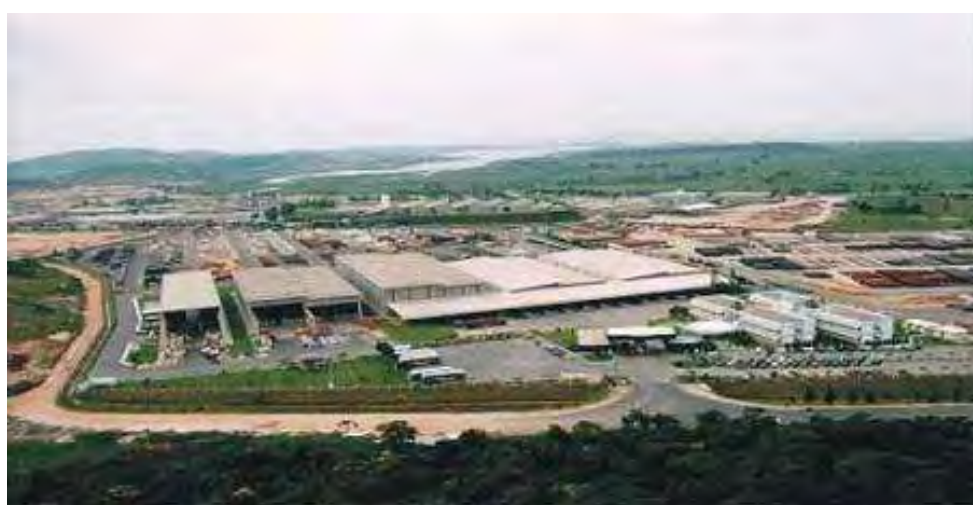
Figura II.2.4-87 - Vista do Parque de Tubos - pátio de armazenamento de tubos, galpões e prédios administrativos.
