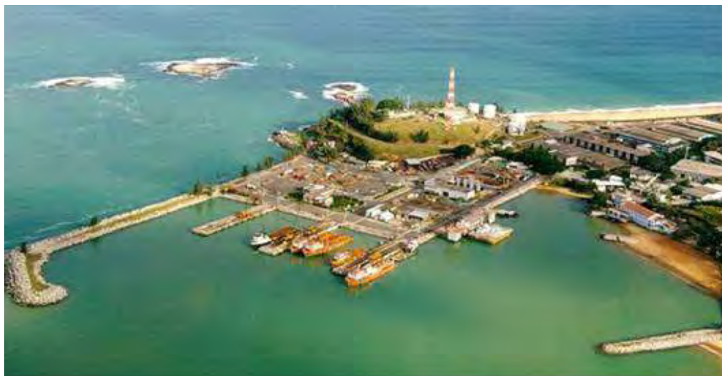
Figura II.2.4-83 - Terminal Alfandegado de Imbetiba.
