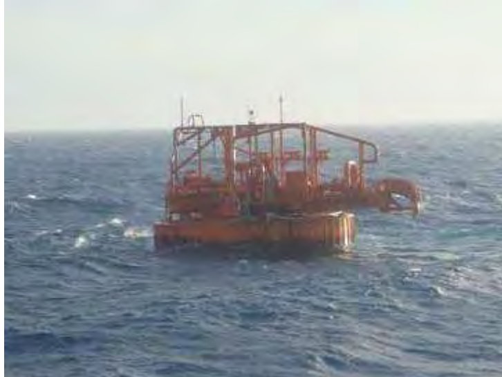
Figura I.1.1-5 – Ilustração de uma monoboia instalada e em operação
