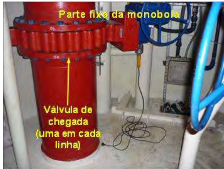
Figura II.2.4-34 - Ilustração da parte fixa da monoboia – válvula de chegada.
