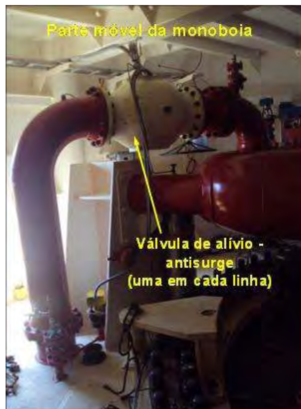
Figura II.2.4-33 - Ilustração da parte móvel da monoboia – válvula de alívio.
