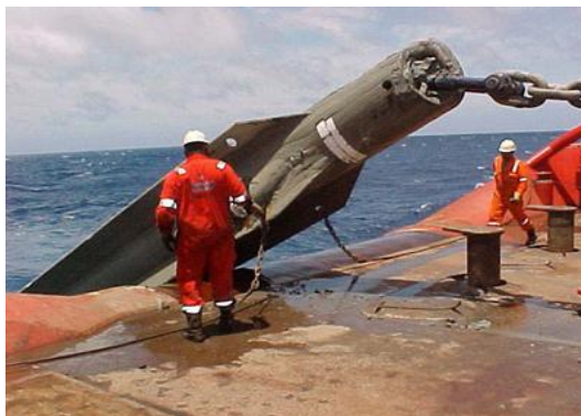
Figura 4 - Foto ilustrativa da instalação dos cabos e âncoras.
