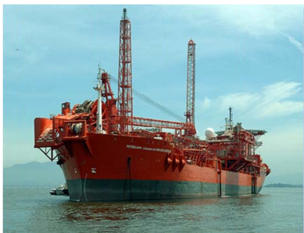
Figura 3 - FPSO Petrojarl Cidade de Rio das Ostras.
