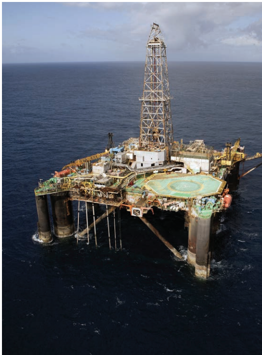
Legenda: Plataforma semi-submersível P-7 operando no campo de Bicudo na Bacia de Campos
