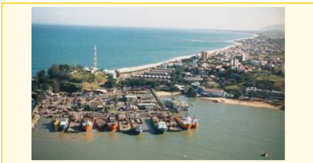
Figura 7 – Terminal Marítimo de Imbetiba, em Macaé (RJ).
