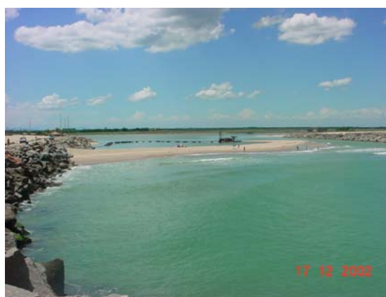
Figura II.5.2-27 - Conexão do Canal da Flecha (Campos dos Goytacazes/RJ) com mar e detalhe do molhe de pedras (guia corrente).
