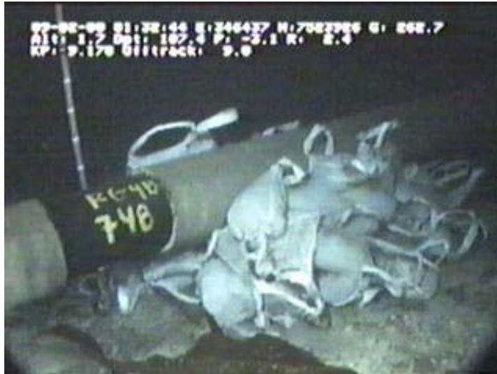
**Figura II.2.4-7 - Calçamento com sacos de concreto.**
