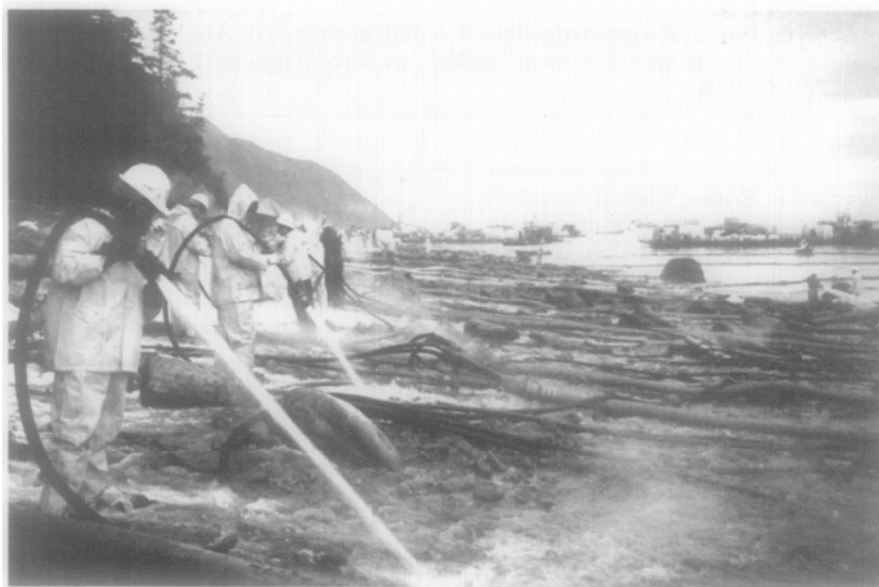
Figura 6: Limpeza agressiva com jateamento de água quente em alta pressão numa praia de seixos no derrame do Exxon Valdez . Foto: "Exxon Valdez" Oil Spill Trustee Council.
