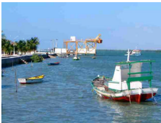
Figura II.5.3-23: Pier de Guararé. Fonte Cristina Aznar
