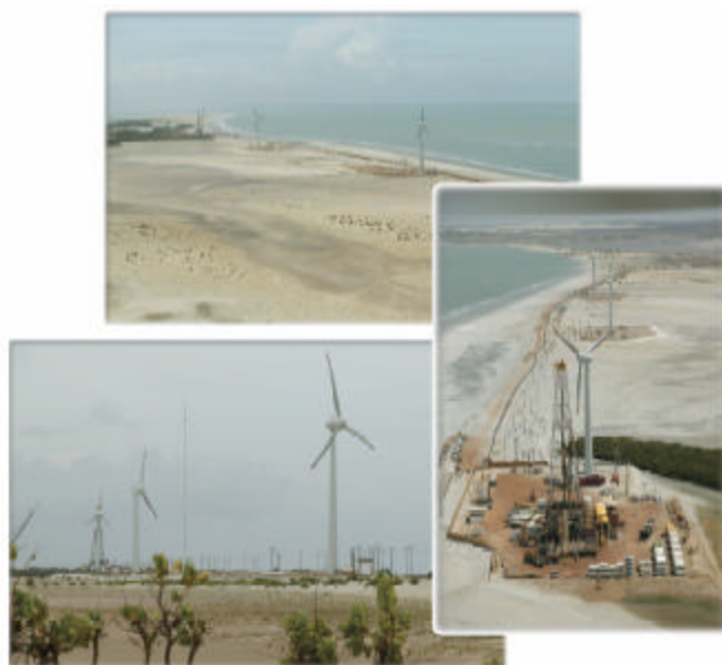
Figura II.5.3-32: Parque Piloto de geração de energia eólica instalado pela PETROBRAS em Macau (RN). Fonte: CRESESB/ CEPEL/ ELETROBRAS ( www.cresesb.cepel.br/ ).
