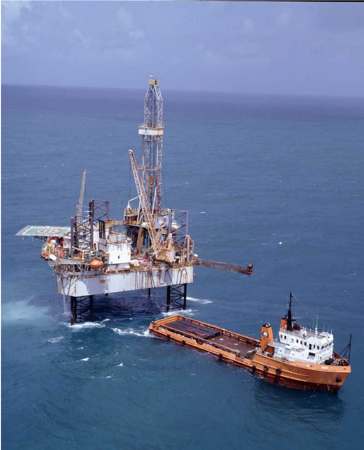
Figura II.2-14: Vista parcial da plataforma PA-09 (P-IV) .
