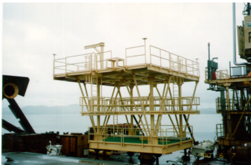
Figura II.2-13: Convés de uma plataforma Caisson
