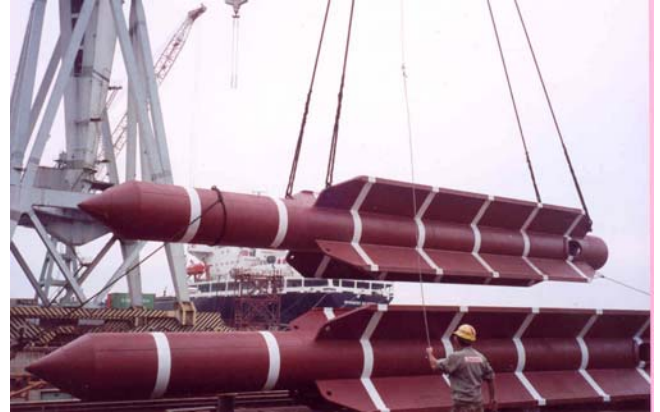
Fonte: Petrobras Figura 06. Estaca do tipo torpedo.
