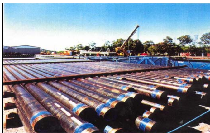
Figura 2.4-39: Parque de tubos no CPVV.
