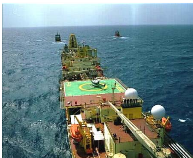
Figura 2.4-21: Heliponto da unidade P-34.
