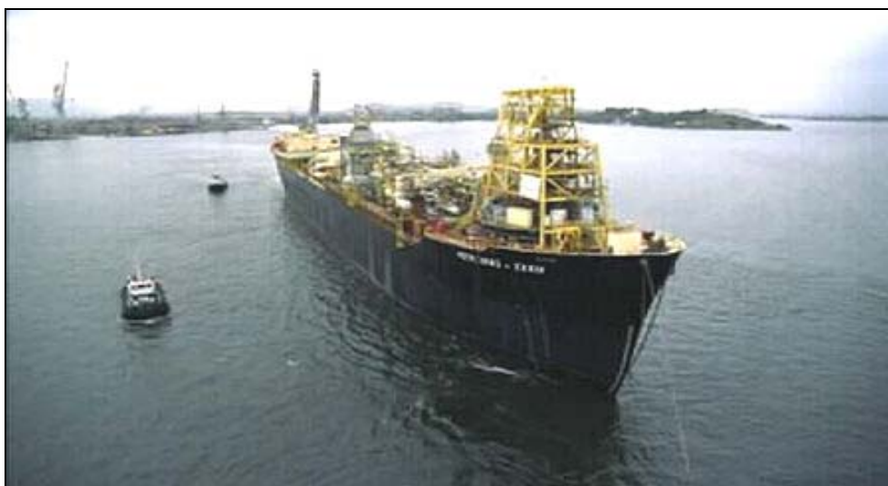
Figura 2-5: Vista da Unidade FPSO P-34.
