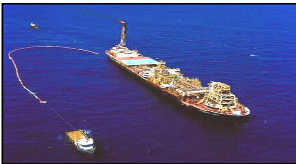
Figura 2.1.4-4: Barco de apoio retorna com mangote de transferência para a P-43.
