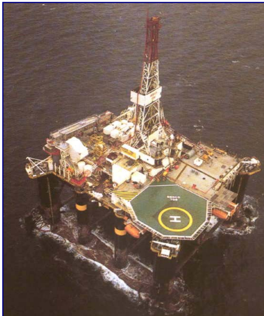
FIGURA II.2.4.1.B-1: TRANSOCEAN SEDCO-706 – UNIDADE DE PERFURAÇÃO MÓVEL SEMI-SUBMERSÍVEL
