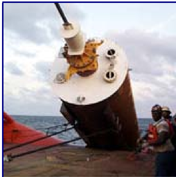
FIGURA II.2.4.2.L-4: OPERAÇÃO DE LANÇAMENTO DE ÂNCORAS DO TIPO DE SUCCÃO. FONTE: www.delmarus.com
