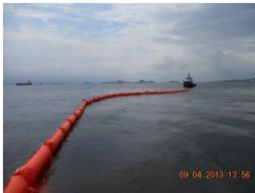
Lançamento Barreira de contenção
