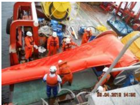
Lançamento Barreira de contenção
