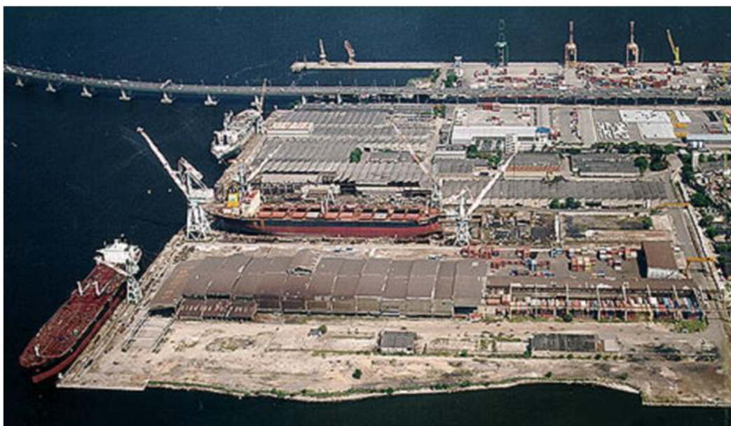
FIGURA II.2.4.20 – Vista aérea da Briclog.
