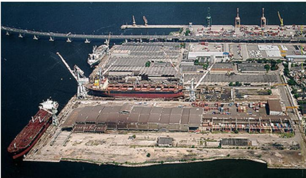
FIGURA II.2.21 – Vista aérea da Briclog.
