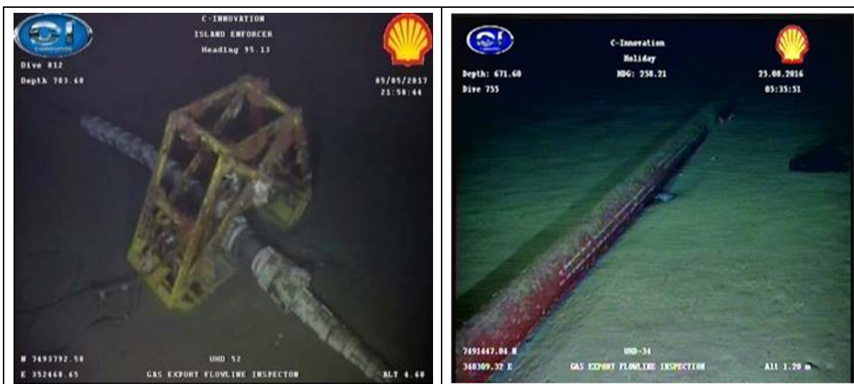
Figura 3.5.1.3 – Valvula Gas Export SSIV à esquerda e linha de exportação de gás à direita
