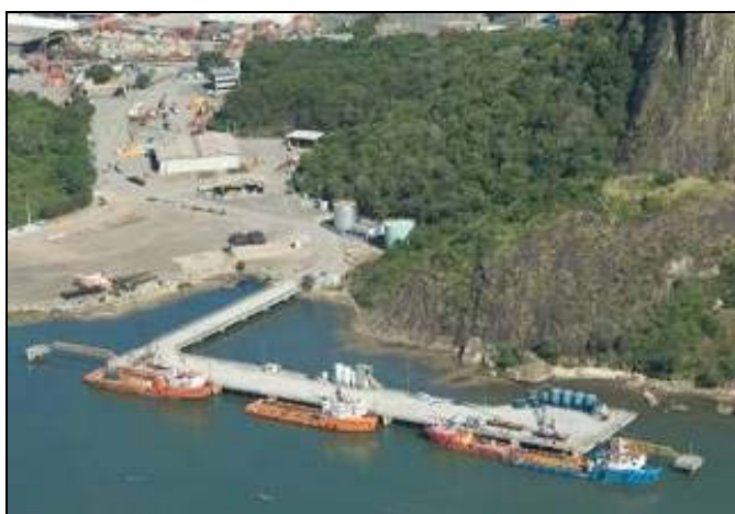
Figura 19: Vista aérea do Terminal da CPVV
