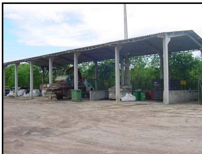
Figura II.2.4-41 – Vista da área para armazenamento temporário de resíduos na CPVV.
