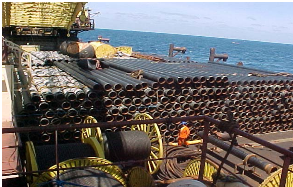
Figura II.2.4-14 - Estaleiro de dutos no interior da BGL-1.
