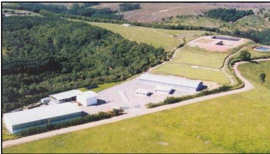
Figura II.2.4-42 - Vista aérea da empresa Vitória Ambiental.
