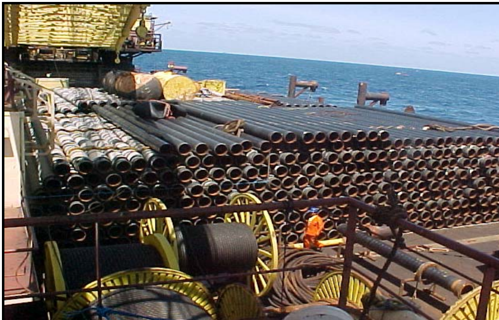
Figura V.2.1-2- Estaleiro de dutos no interior da BGL-1
