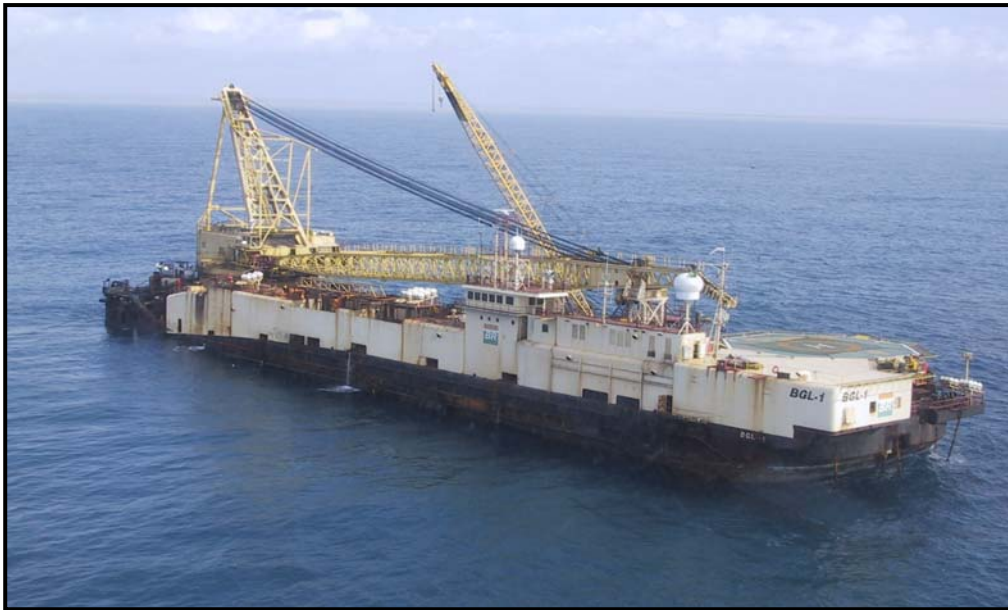
Figura V.2.1-1 - Balsa Guindaste para lançamento do gasoduto em águas rasas
