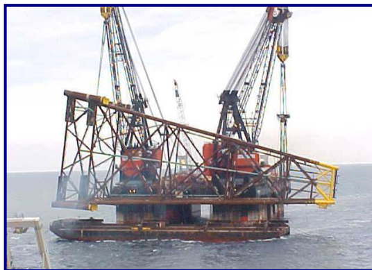
FIGURA II.2.4.1.B-5: EXEMPLO DO PROCESSO INICIAL DE IÇAMENTO DA JAQUETA (FONTE: DEVON)
