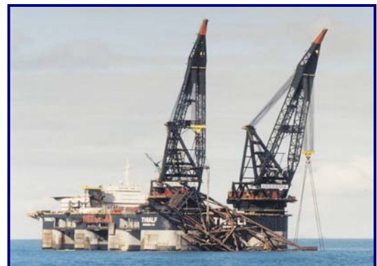
FIGURA II.2.4.1.B-6: EXEMPLO DO PROCESSO DE SUBMERSÃO PROGRESSIVA DA JAQUETA (FONTE: DEVON)
