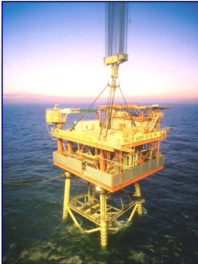
FIGURA II.2.4.1.B-8: EXEMPLO DE ASSENTAMENTO DE CONVÉS (FONTE: DEVON)
