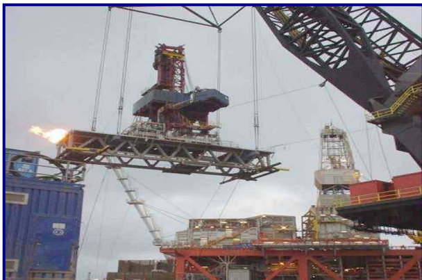
FIGURA II.15-6: EXEMPLO DO IÇAMENTO DA SONDA DE PERFURAÇÃO
