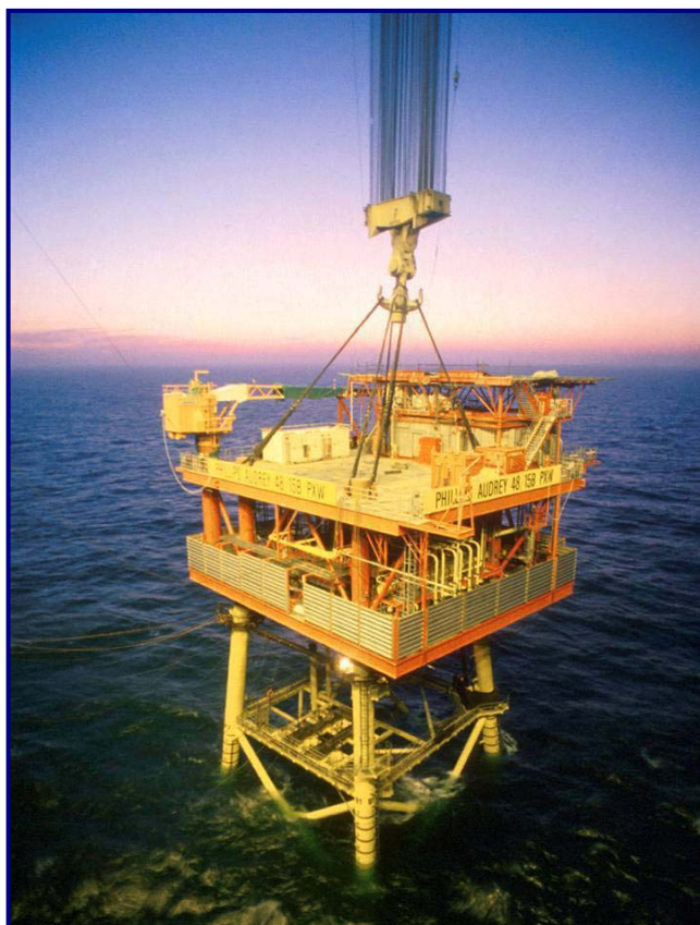
II.15-10: EXEMPLO DA OPERAÇÃO DE INSTALAÇÃO DO CONVÉS
