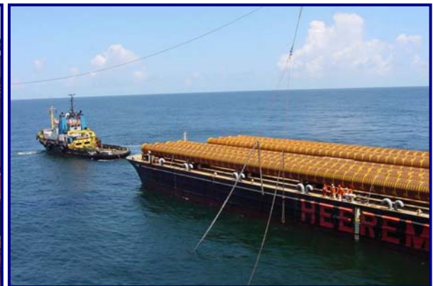
FIGURA II.15-7: EXEMPLO DO TRANSPORTE DAS ESTACAS DE FUNDAÇÃO DA PLATAFORMA
