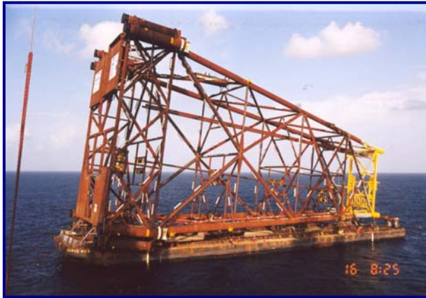
FIGURA II.15-4: EXEMPLO DO TRANSPORTE DA JAQUETA
