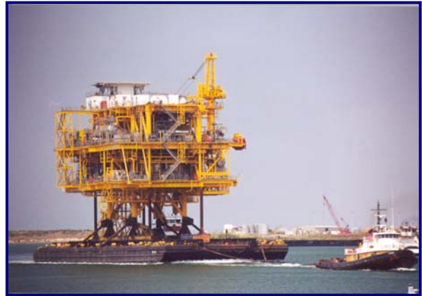
FIGURA II.15-5: EXEMPLO DO TRANSPORTE DOS CONVESES
