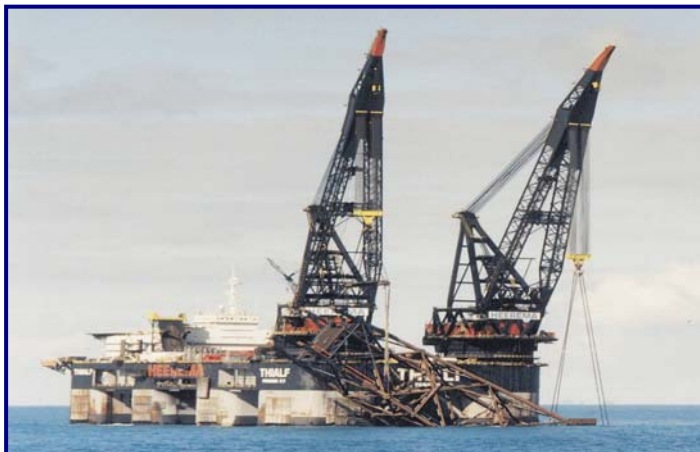
II.15-9: EXEMPLO DO PROCESSO DE SUBMERSÃO PROGRESSIVA DA JAQUETA
