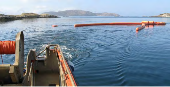
Fig. A11: Com a ajuda de um guincho, o comprimento de um dos cabos de reboque é ajustado para que o NOFI Current Buster mantenha uma boa formação durante a curva.
