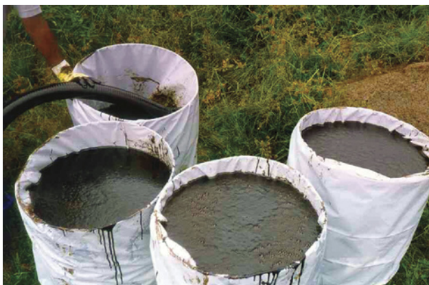
15.3. Recolhimento de resíduo oleoso a vácuo e armazenagem temporária em tambor. Banco de Imagens da CETESB
