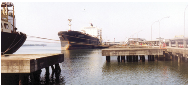
8.1. Terminal aquaviário da Alemoa, Santos (SP). Banco de imagens da CETESB
