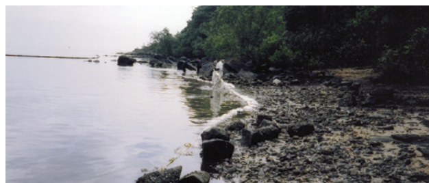
7.12. Aplicação de pompons de modo análogo à aplicação das barreiras absorventes. Banco de imagens da CETESB
