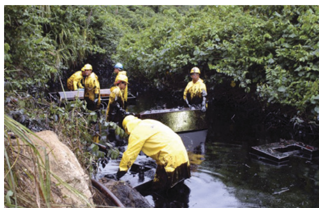
7.9. Equipes trajando EPI durante remoção manual de óleo em corpo d'água, São Sebastião (SP). Banco de imagens da CETESB.
