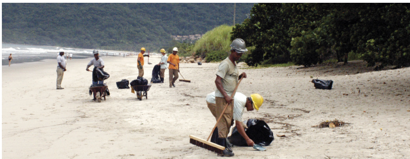
3.5. Remoção manual. Vazamento em oleoduto, São Sebastião, SP. Banco de imagens da CETESB.
