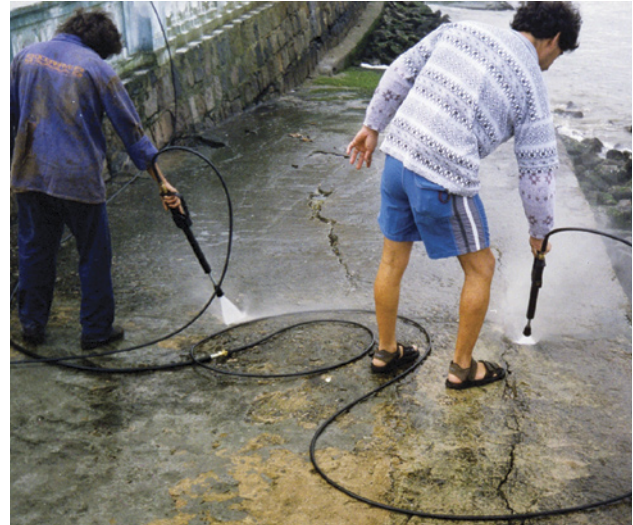
8.9. Detalhe de jateamento a alta pressão em rampa contaminada, Santos ( SP). Banco de imagens da CETESB
