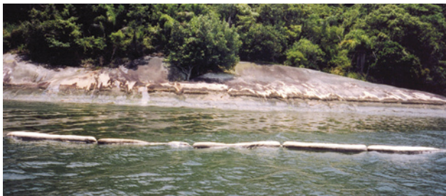
7.11. Barreiras absorventes aplicadas adjacentes a costões atingidos por óleo. Banco de imagens da CETESB.
