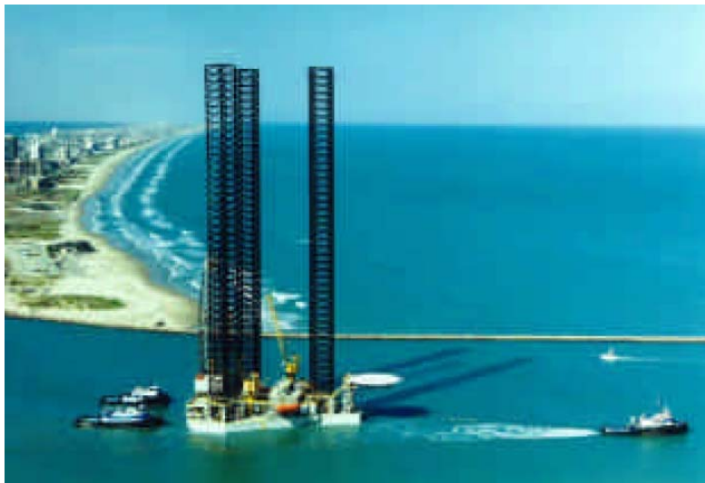
Figura 3.1-1. Plataforma tipo autoelevável em reboque. Fonte: OGX
