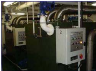
Unidade de Tratamento de Esgotos (UTE)
