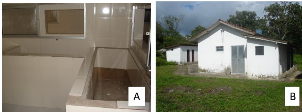
FIGURA II.5.3.5.11 – Unidade de beneficiamento de Caratateua: áreas interna “A” e externa “B”.
