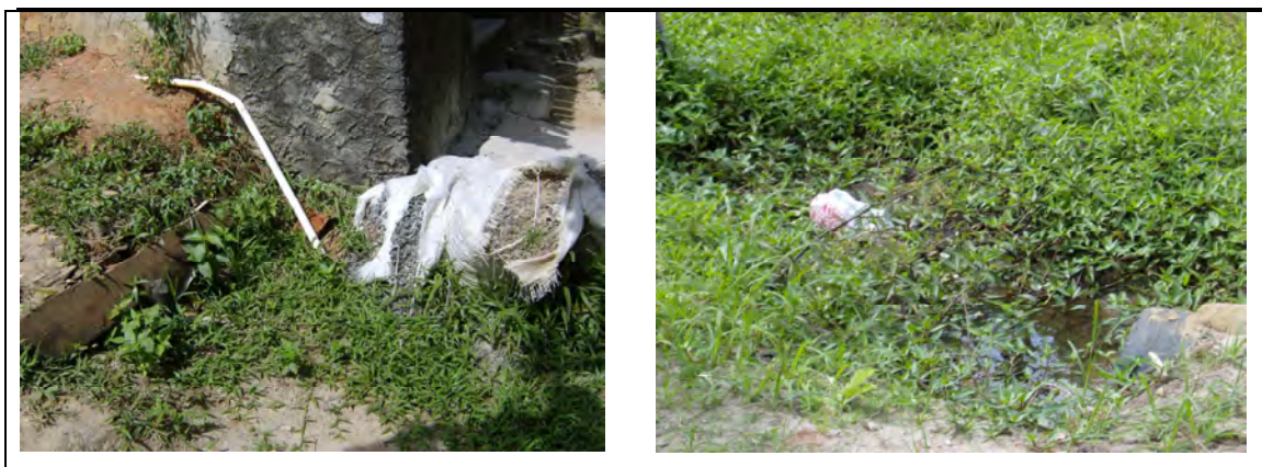
Figura II.5.3.M.3-6 - Lançamento de esgoto no sistema fluvial.
