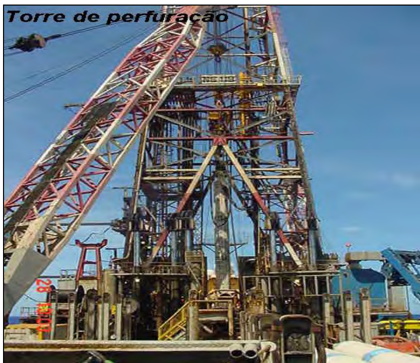
Figura II.3.B-2 - Torre de Perfuração do NS-09 S.C. Lancer.
