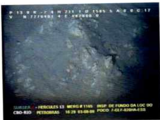
NE da locação
