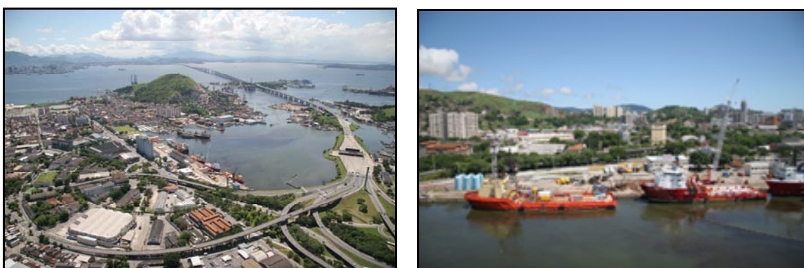
Figura II.3-12 - Vistas Aéreas da Base de Apoio NITSHORE
