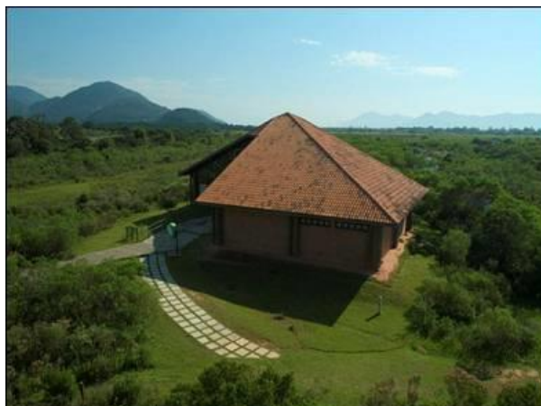
FIGURA 9 – Parque Estadual da Serra do Tabuleiro
