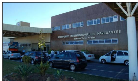
Figura 32: Aeroporto de Navegantes (SC).
