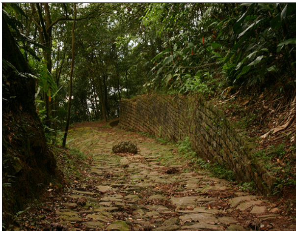
Figura 51: Calçada do Lorena, Cubatão - SP.
