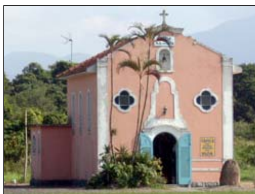
Figura 49: Capela de Nossa Senhora da Guia, município de Praia Grande - SP.
