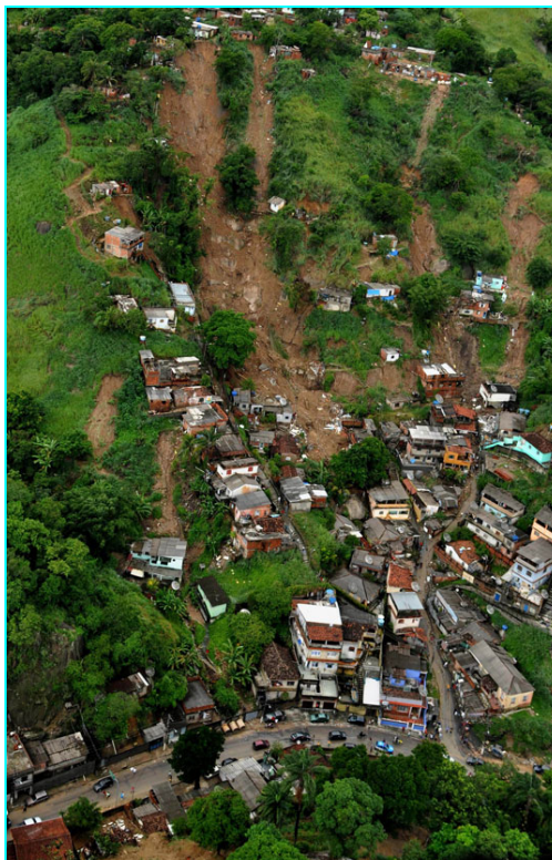
Figura I.2.2.1-61 - Deslizamento no Morro do Bumba – Niterói/RJ.
