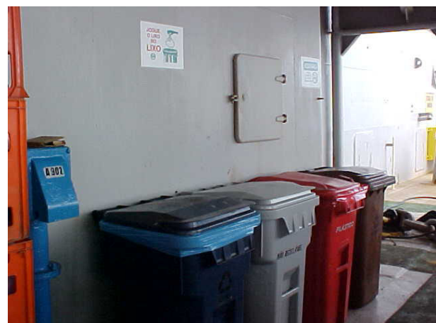
Figura II.10.2-2 - Coletores seletivos na área de acesso à parte interna da plataforma.
