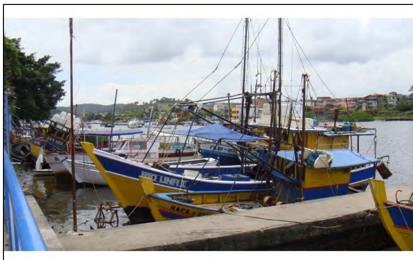
Figura II.5.3- 118 - Vista geral do cais no bairro do Tento – Valença.
