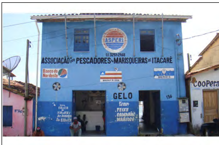
Figura II.5.3- 100 - Sede da Associação dos Pescadores e Marisqueiras de Itacaré.
