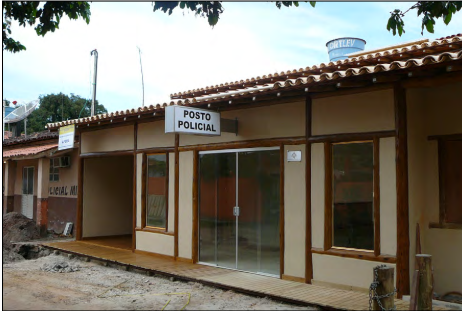
Figura II.5.3-18 - Posto policial em Construção - Barra Grande.
